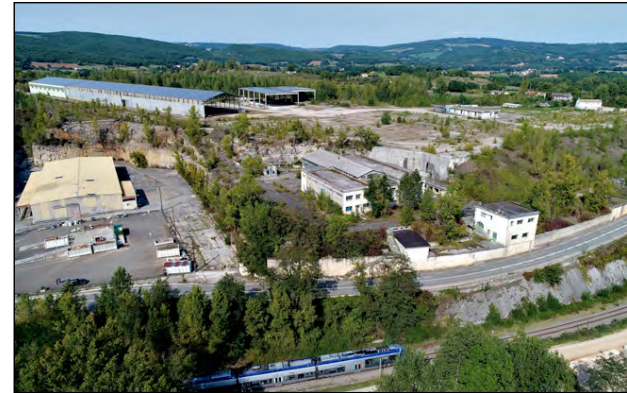
Le site de Lexos aujourd'hui ; la cimenterie a disparu, on voit bien la place occupée par la première usine.
