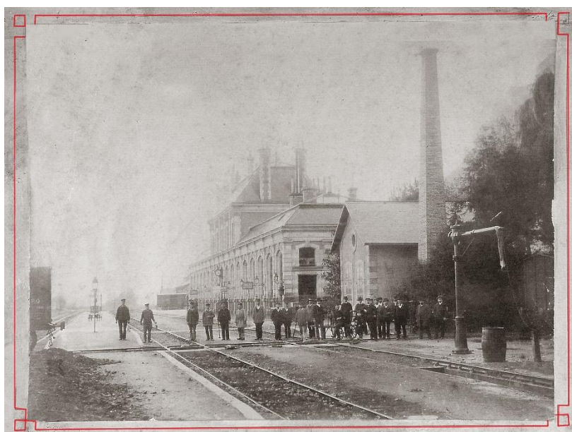
Gare de LEXOS vers 1900 avec son personnel, la station de pompage et la lance de remplissage
